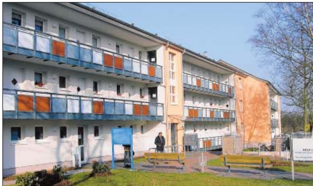
Sanierter Bau an der Frankfurter Straße 31-33 in Schwarzenbek. Hier befindet sich das erste Service-Center als Anlaufstelle für die 900 Mieter aus Schwarzenbek, wenn sie technische oder persönliche Probleme haben. Von hier aus werden auch die Genossenschaftsstandorte Wentorf, Börnsen, Geesthacht, Lauenburg, Mölln, Trittau, Basthorst und Breitenfelde sowie Büchen betreut.
