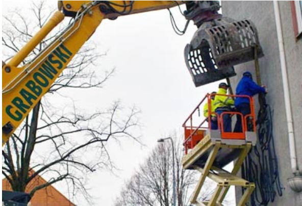
Am Kaufhof haben die Abbrucharbeiten begonnen. Fotos: JW
