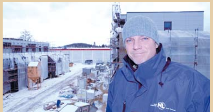
NL-Projektleiter Henrik Günther auf „seiner“ Baustelle im Nussbaumweg.
