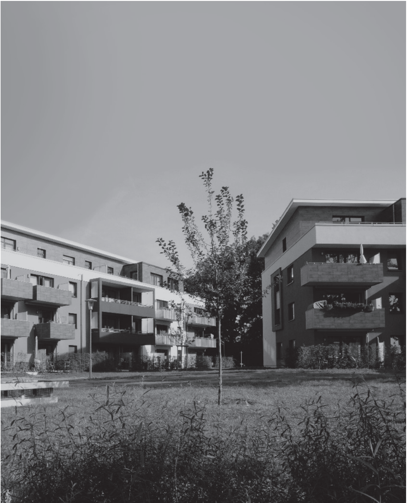
Neubau in Lübeck-Eichholz, Brandenbaumer Landstraße
