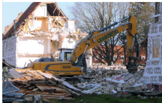
Abriß für den Neubau in Eichholz
