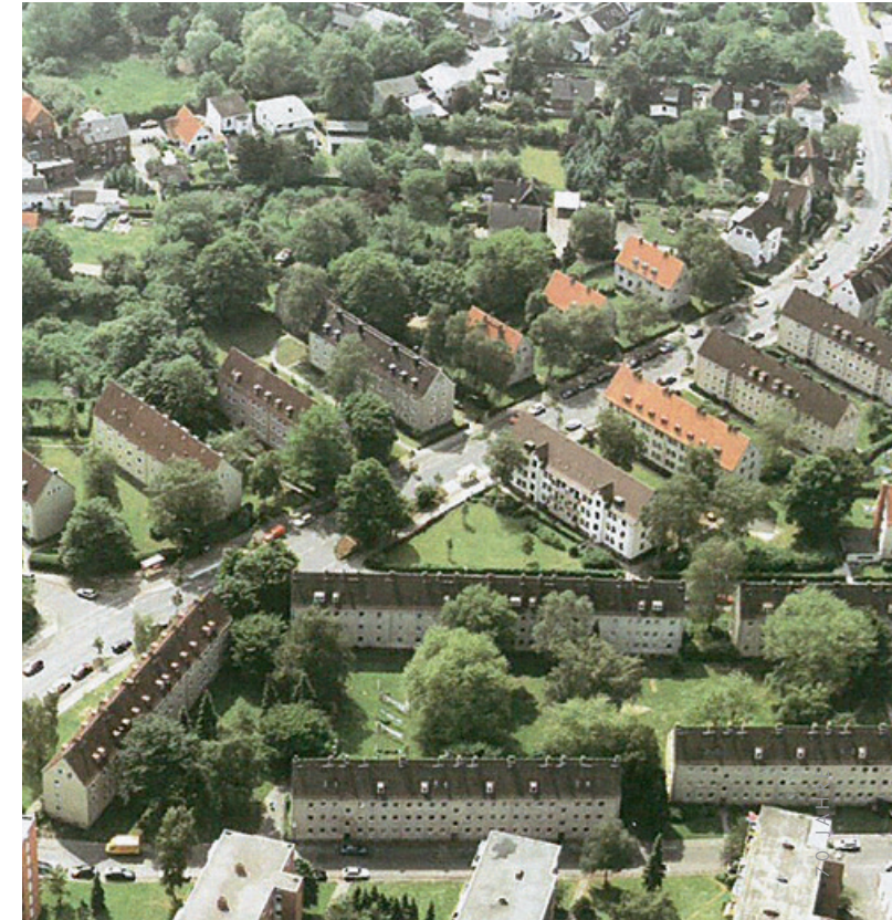
472 Wohnungen übernahm die NL in der Gerberstraße in Elmshorn
